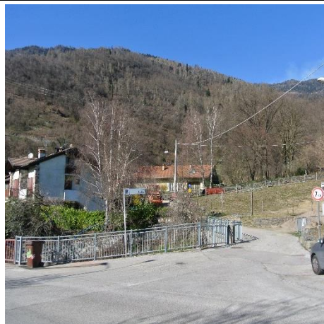
Vista a valle, collegamento con SP11
